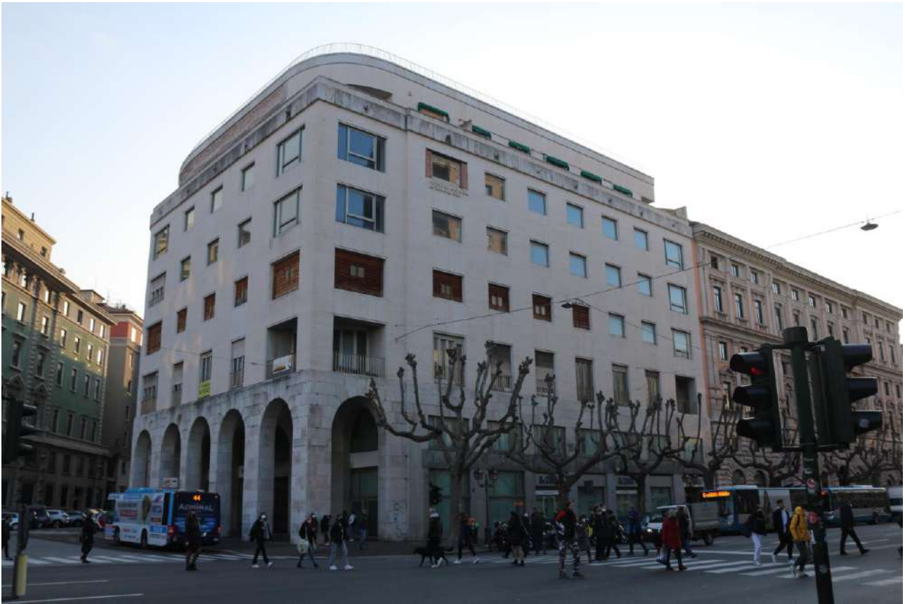
FOTO n°3. - visione esterna – LOTTO 1
