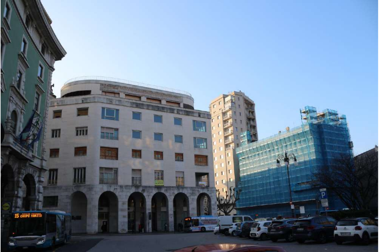
FOTO n°1. - visione esterna – LOTTO 1
