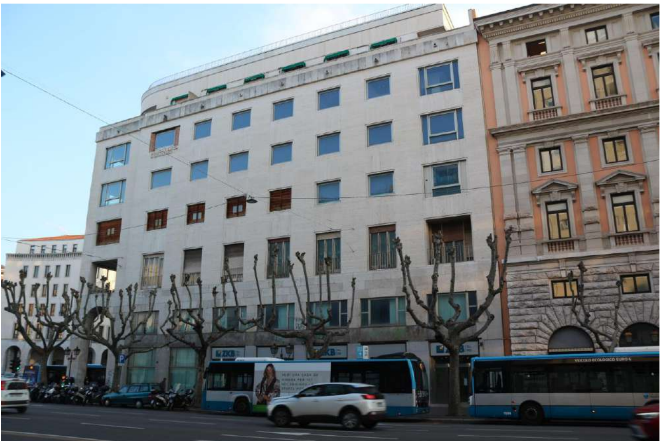
FOTO n°2. - visione esterna – LOTTO 1
